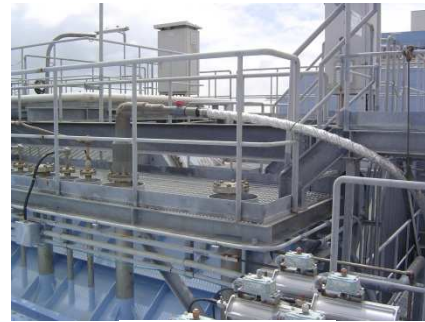
排ガス引込口
